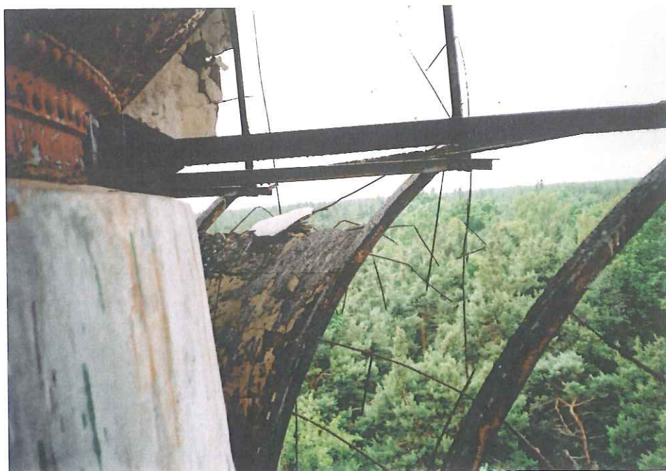
Fot.8 Podstawa zbiornika wody . Korozyja bąbelkowa . Całkowicie zniszczony fragment ścianki obudowy. Zadawalający stan wieńca podpierającego zbiornik.
