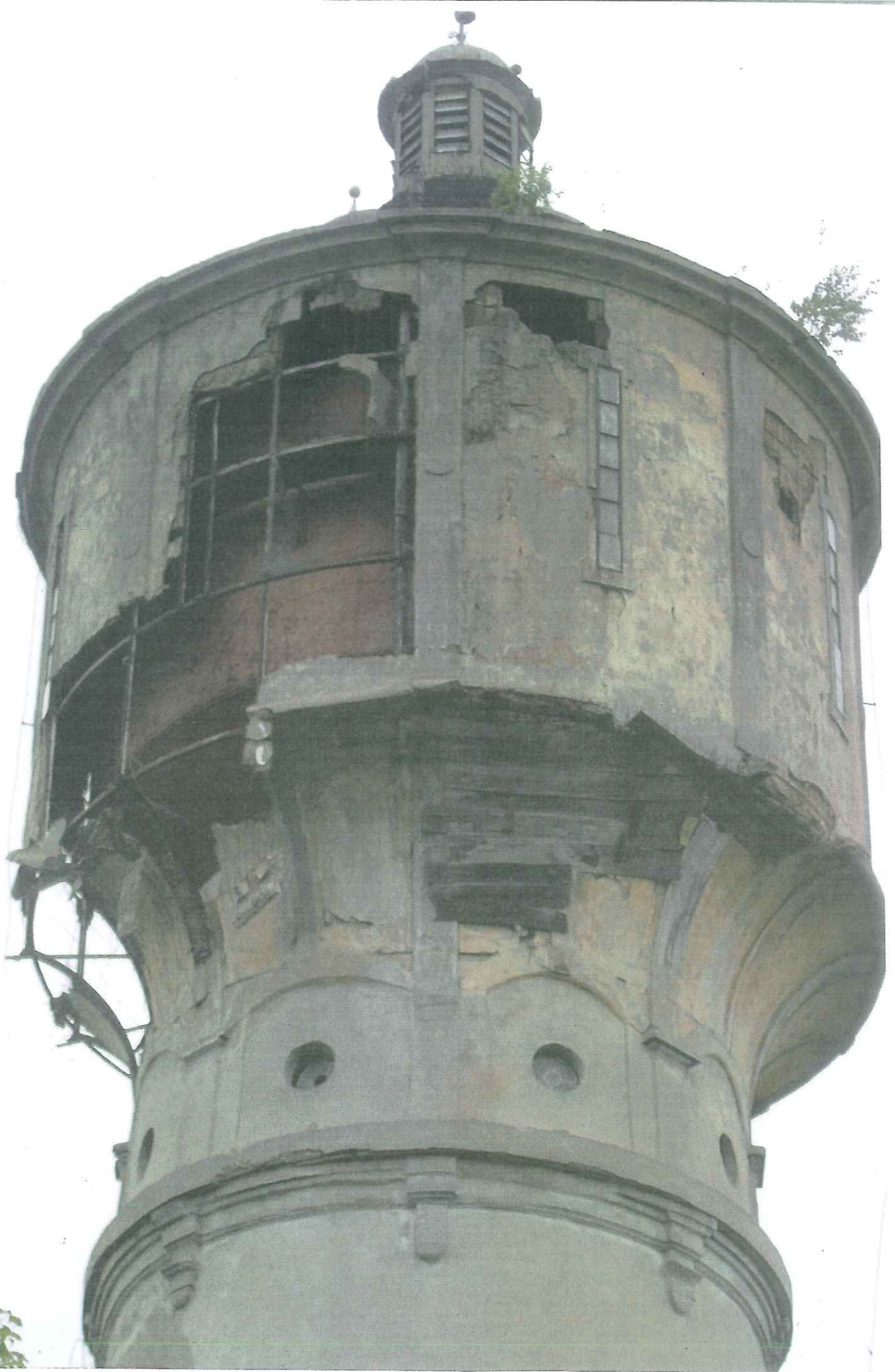
Fot.6 Stan awaryjny ścian obudowy zbiornika stalowego
