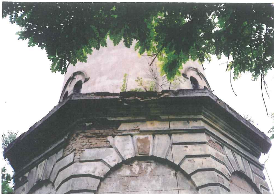
Fot.2 Ściana zewnętrzna nad parterem. W odsłoniętej części muru widoczne ubytki spoin pionowych .Gzyms i tynki w stanie destrukcji .
