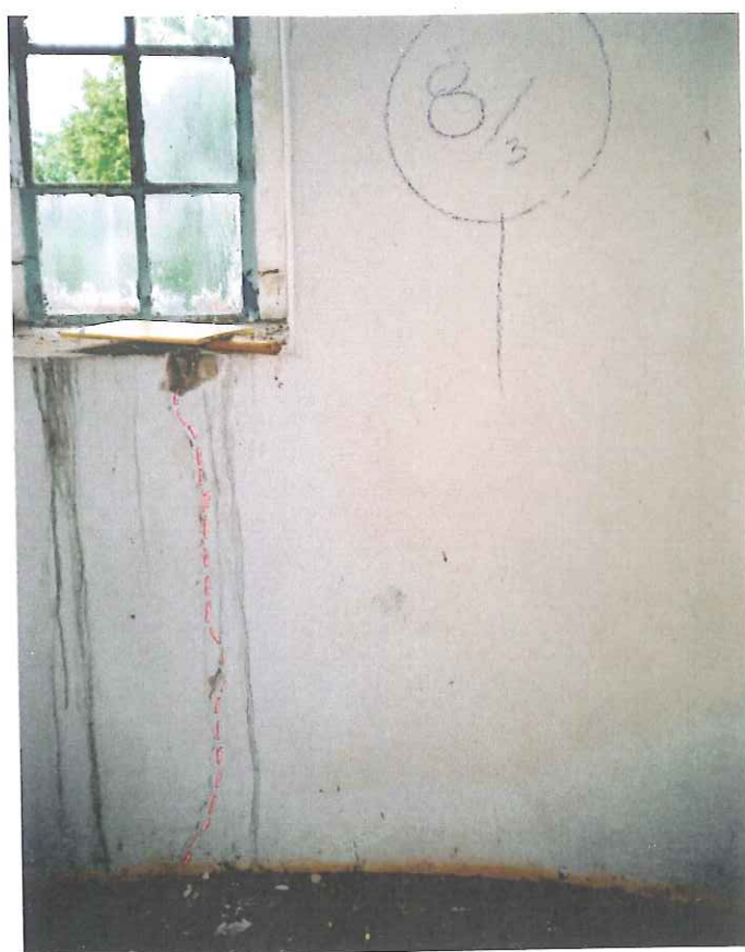
Fot.5 Pęknięcie muru na poziomie nr 3 oraz czarne naloty pleśni.
