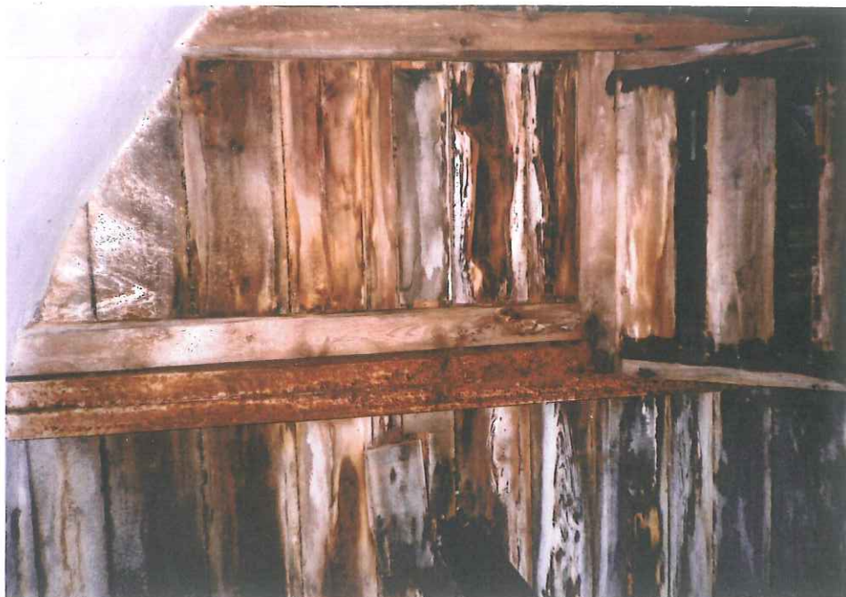
Fot.7 Strop drewniany „goły” na belkach drewnianych Widoczne białe naloty grzybni Grzyba domowego białego (poria vaporaria) oraz Powłoczniaka gładkiego (Corticium laeve) Stalowa belka podpierająca- korozyja bąbelkowa.
