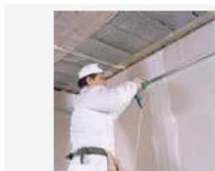
Na każdej ścianie wyznaczamy poziom zamocowania sufitu. Rysujemy poziome linie przy użyciu poziomnicy. Wzdłuż linii montujemy profile UD.
