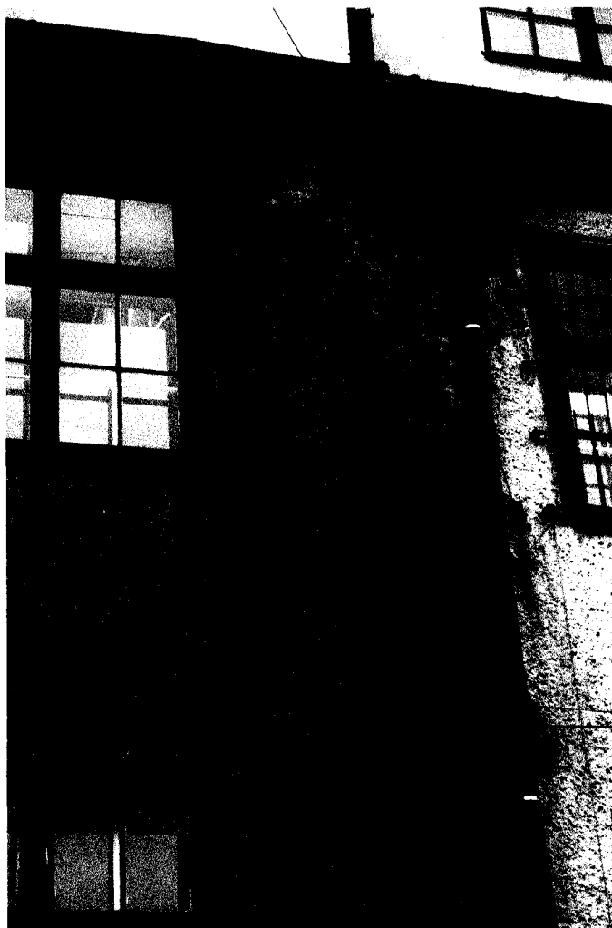
Elewacja skorodowana na skutek nieszczelności obróbek blacharskich.
