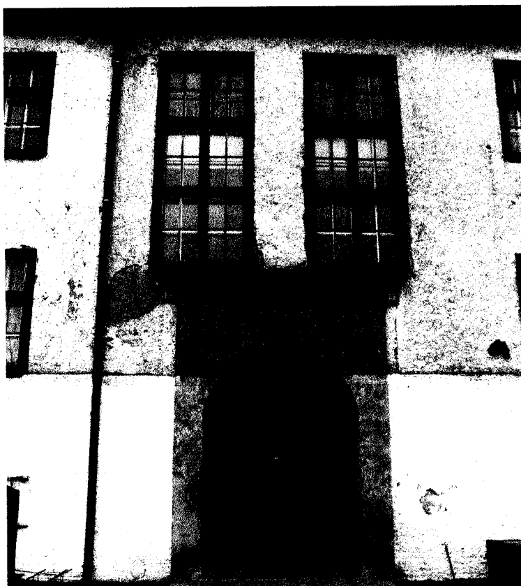
Nieszczelne rynny ubytki tynków
