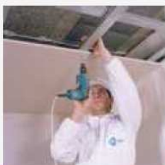
Po zmontowaniu siatki rusztu mocujemy do profili płyty gipsowo-kartonowe. Później wykańczamy spoiny.
