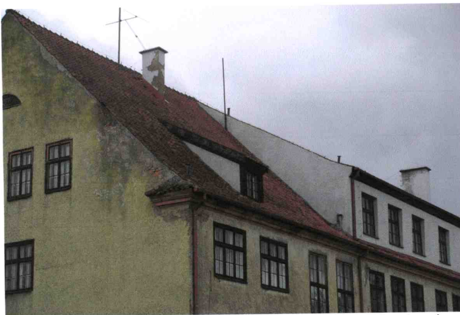
Ubytki tynku na ścianie szczytowej oraz w pobliżu rury spustowej
