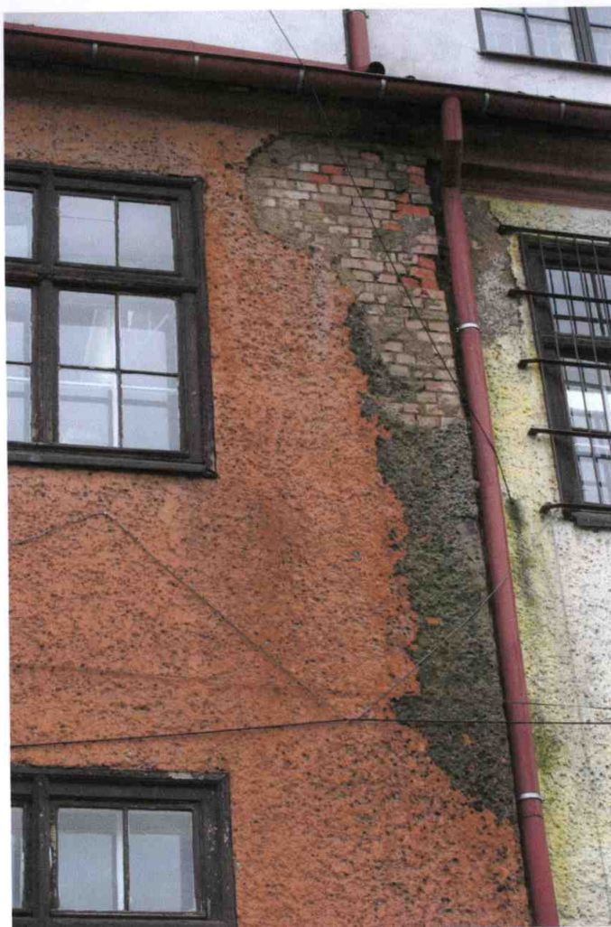
Elewacja skorodowana na skutek nieuszczelności obróbek blacharskich.
