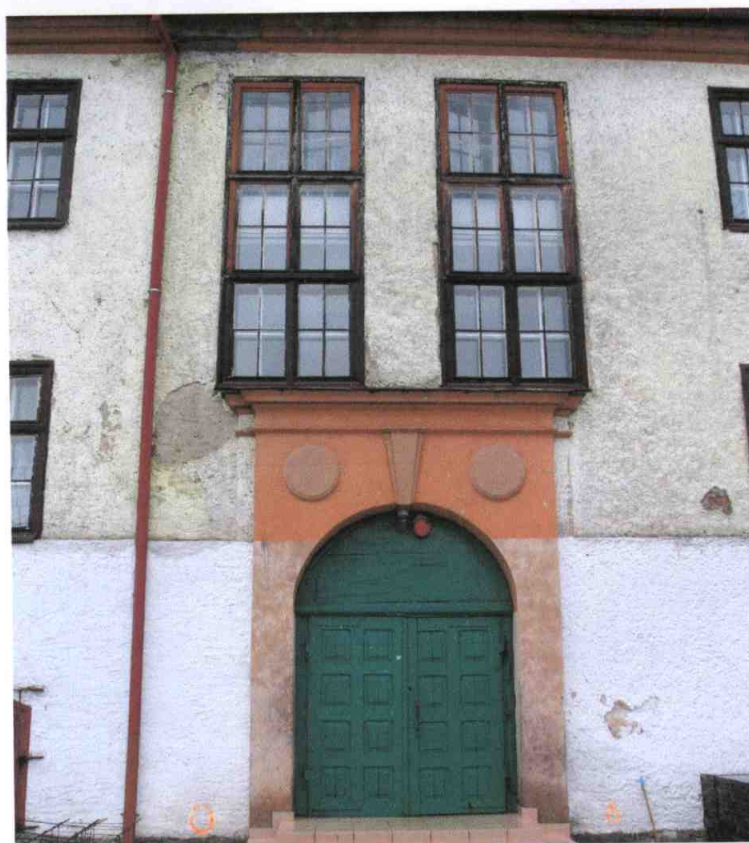
Nieszczelne rynny ubytki tynków
