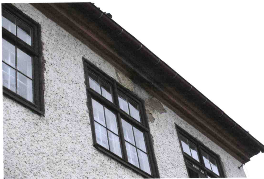
Nieszczelne rynny ubytki tynków
