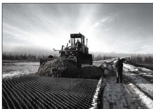
Rys. 6. Zasypywanie kruszywem komórek geosiatki za pomocą równiarki
